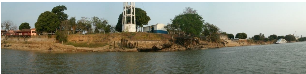
Figura 7 Ponto de captação de água para abastecimento público, Cáceres – MT, no período de estiagem
